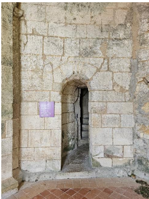
Entrée de la tour du clocher
