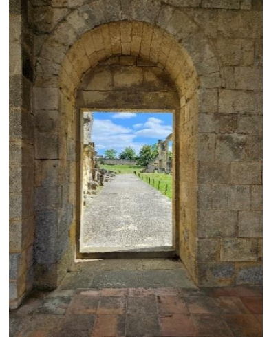
Vue sur l'allée bitumée et accès au bas-côté sud (marche de 11cm)
