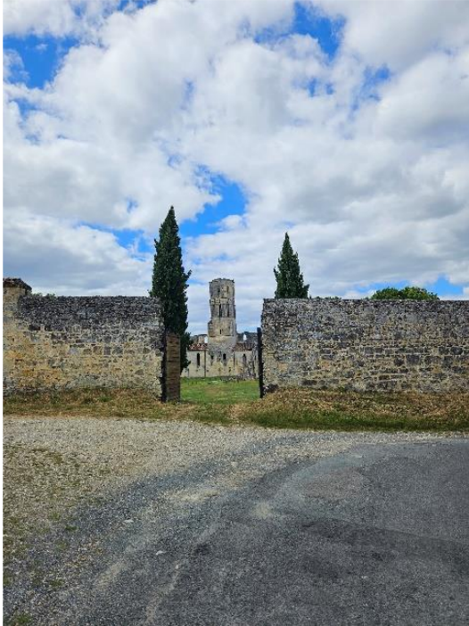
Entrée du parc pour les PMR via le portail en bois
