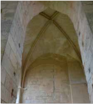
Voûtes gothiques, collatéral sud
