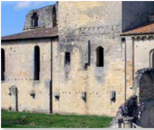
En saillie, les restes des chapiteaux qui recevaient les départs de voûtes du cloître
