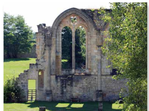
Mur du réfectoire.
